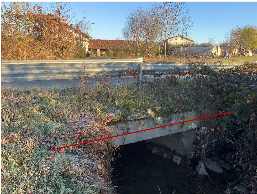
Figura 11 – Posa tubazione mediante staffaggio a ponte
