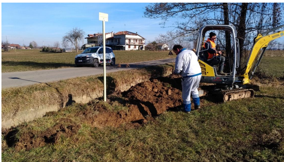
Figura 12 – Picchettamento gasdotto con personale SNAM
