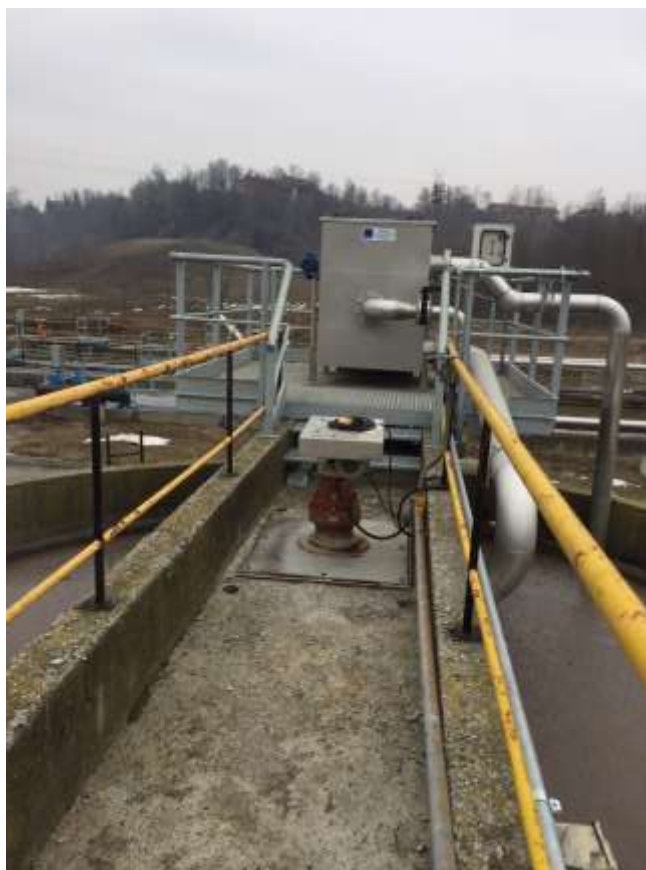
Rotostacciatura dei fanghi
