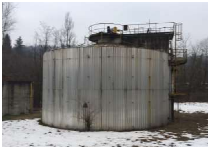
Figura 17 - Digestore anaerobico (dismesso)
