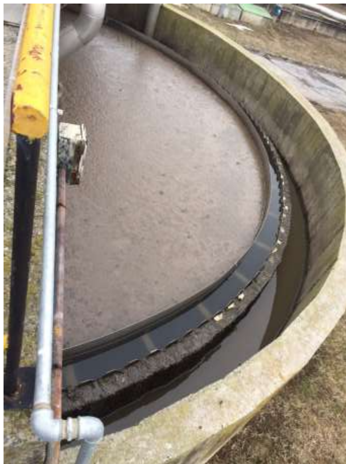
Ispessimento dei fanghi di supero
