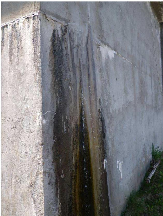
Foto 3 e 4 – Serbatoio esistente, particolari delle lesioni e perdite
